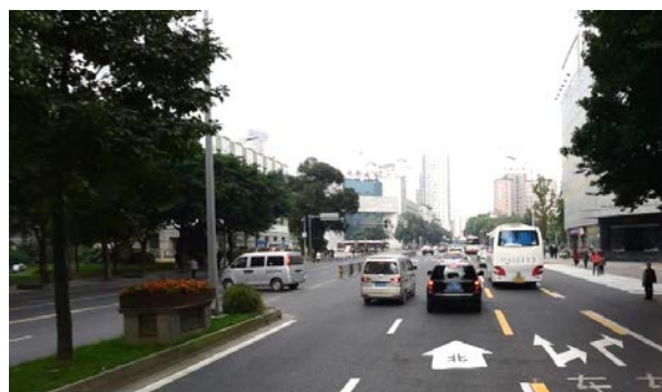
图 1.8 东城根下街去除中央分隔带展宽
