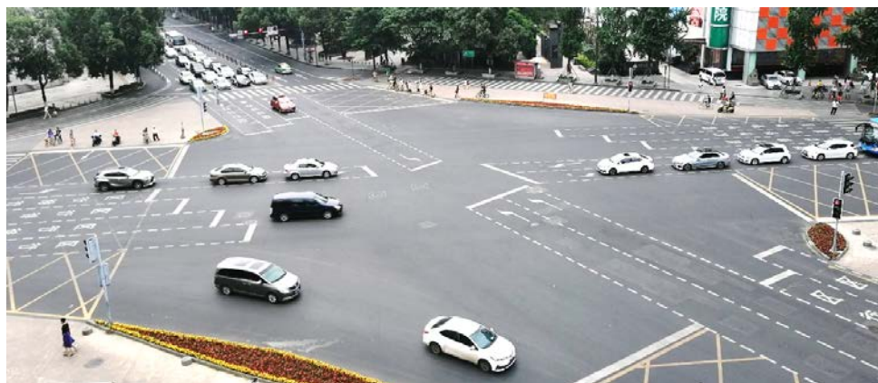
图 1.2 八宝街-东城根下街交叉口实景
